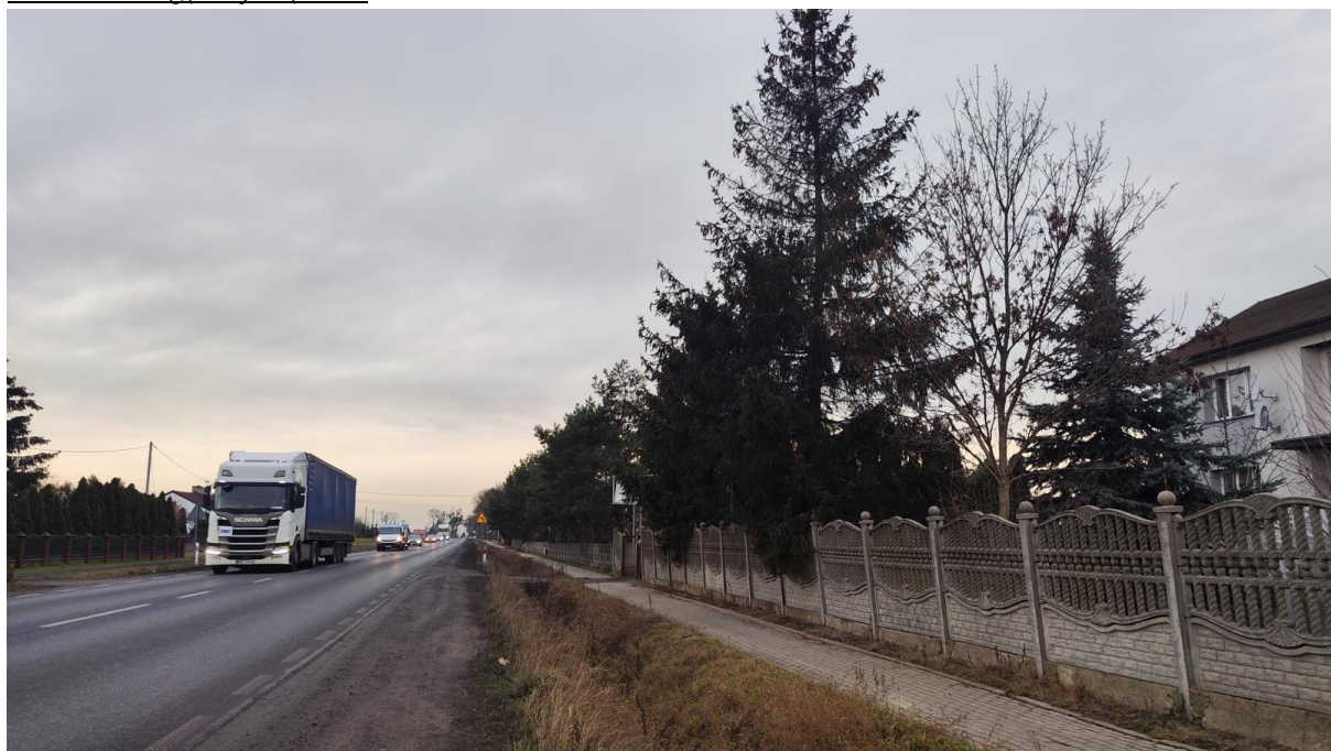
Widok na drogę krajową nr 60
